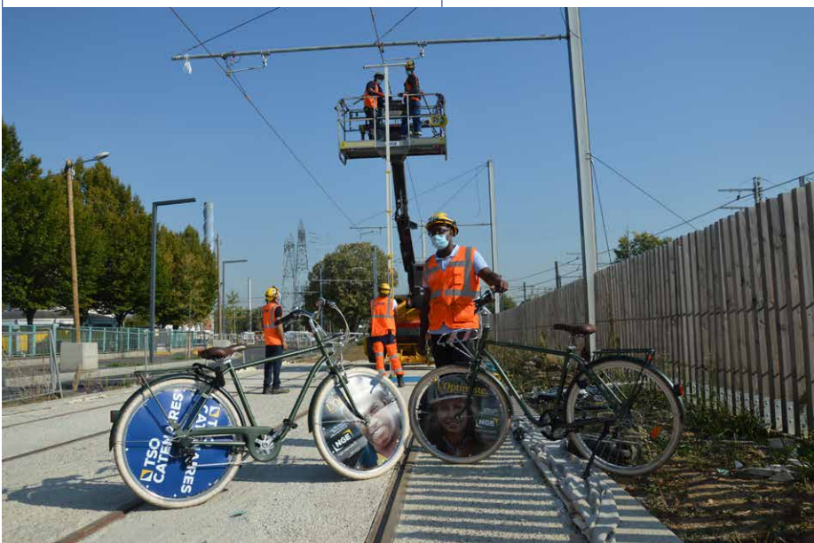
▲ Chantier tramway T9
